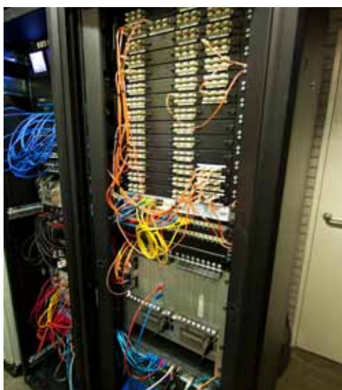
Rack met een van de twee DSP-cores, in de serverruimte. Eronder de dubbele voeding, daar weer onder de aparte server voor VST-plugins. | FOTO'S: ©PETER FIZGAL |
